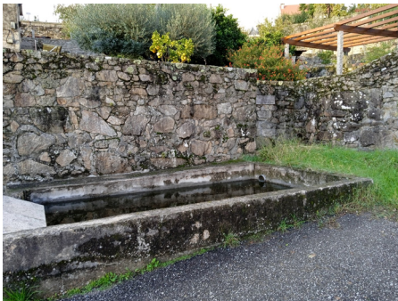
Poza da Rachadura.
