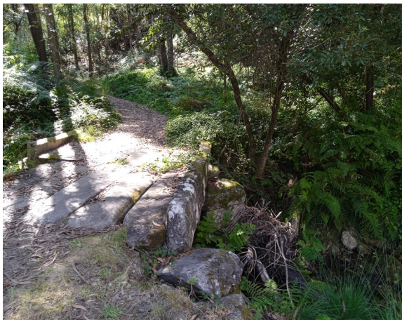
Ponte de Xan Garrido.
