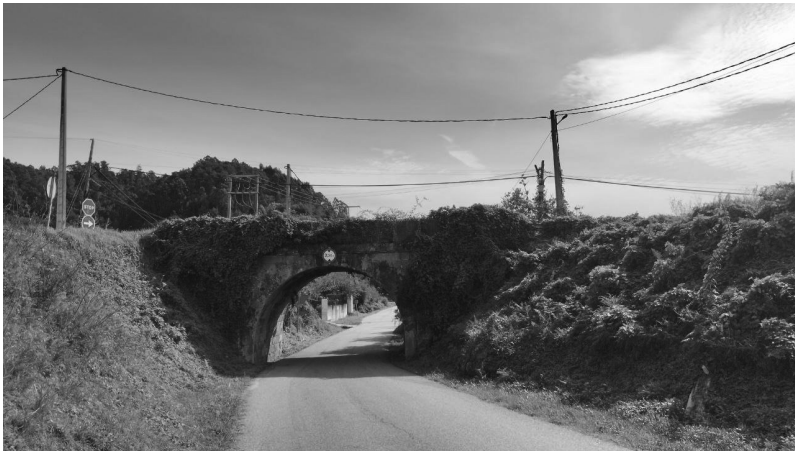
A Ponte de Quintela
